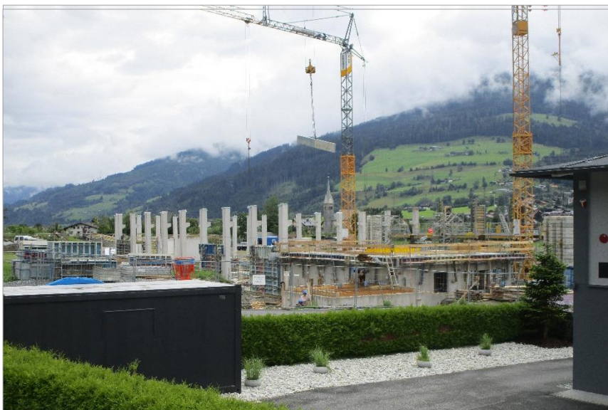
Zell-Metall noch als Baustelle, hier sollen in Kürze 100 Arbeitsplätze entstehen.
